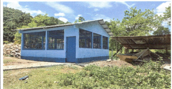
Foto 4: COLOCACION DE PUERTA Y BALCONES DE LA COCINA.
