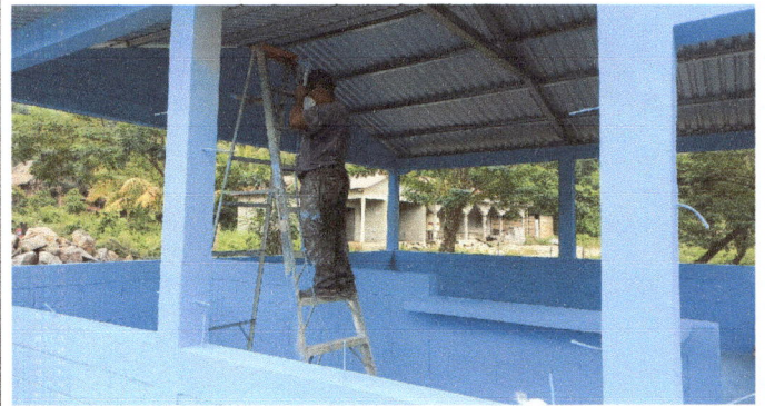
Foto 2: PINTANDO INTERIOR DE LA COCINA.
