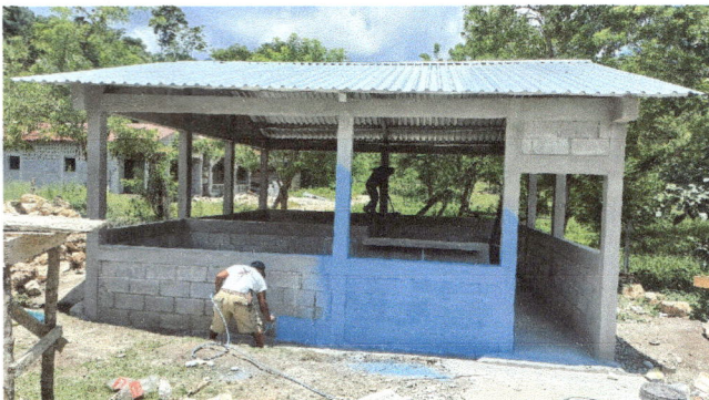
Foto 3: PINTANDO PARED EXTERIOR DE LA COCINA.
