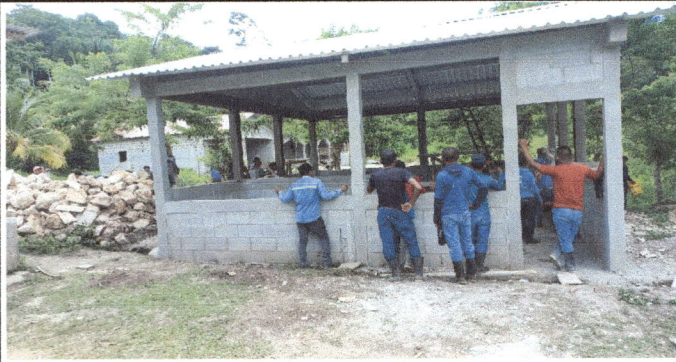
Foto1: COLOCANDO BALCONES DE LA COCINA.
